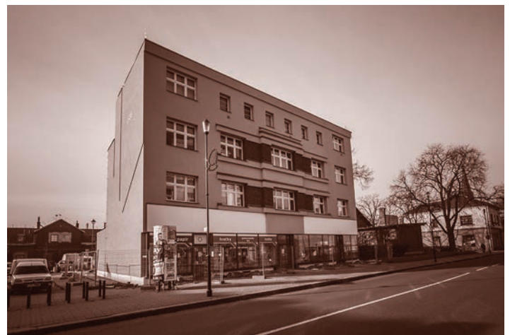
Na sklonku listopadu finišovala rekonstrukce fasády domu v ulici Jeremenkově 16.
